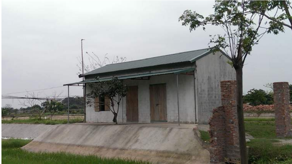
a) Nhà một tầng có cột bê tông cốt thép, tường gạch và mái lợp tôn
