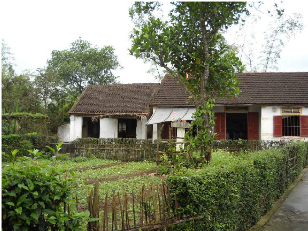
b) Nhà một tầng, mái ngói
