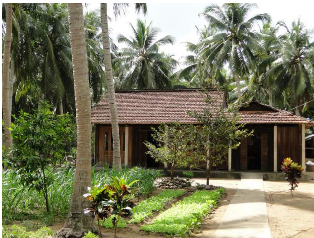
b) Nhà một tầng, mái ngói
