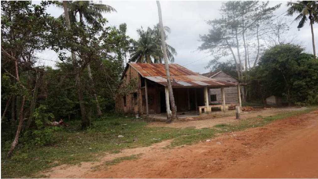
a) Nhà một tầng chỉ có tường xây gạch bền chắc, không có cột, mái lợp tôn
