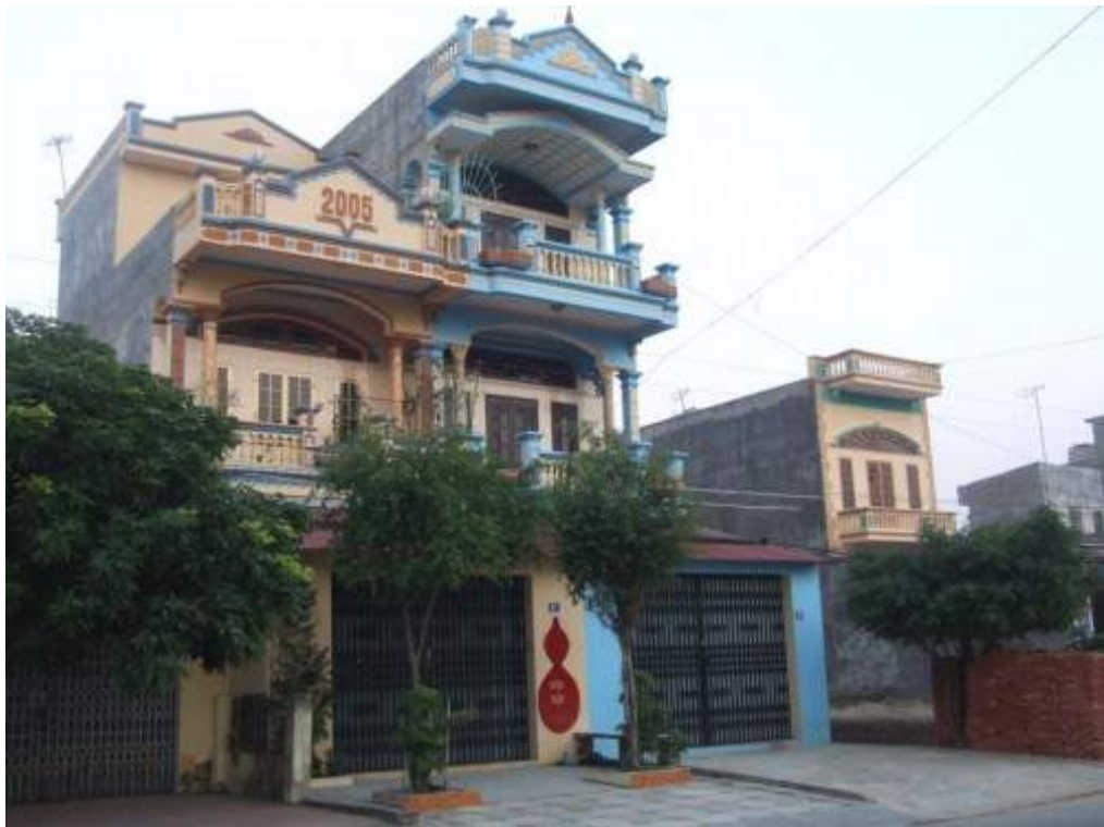
b) Nhà ba tầng, mái bằng bê tông cốt thép
