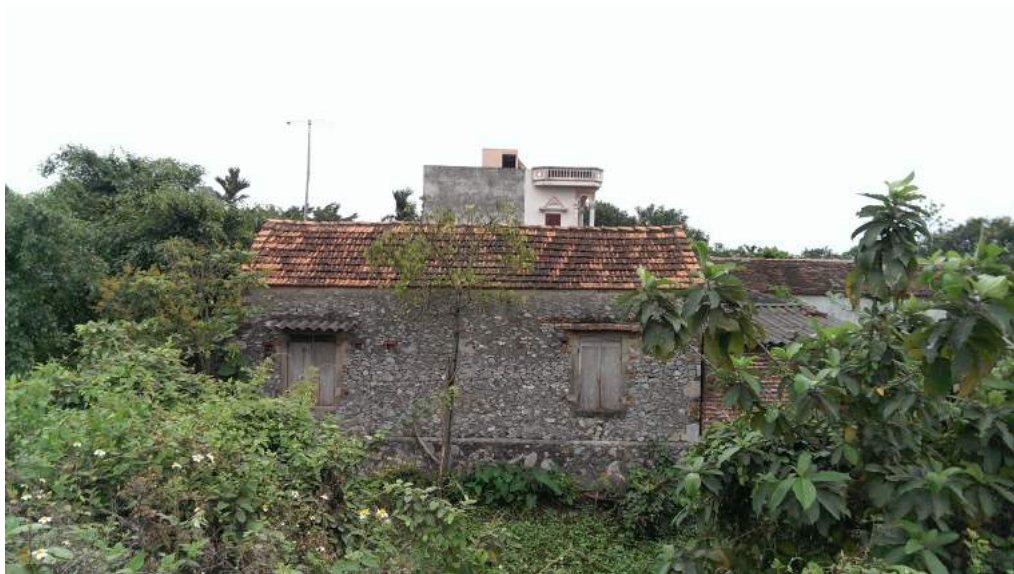
b) Nhà một tầng, tường xây đá không có cột, mái ngói
