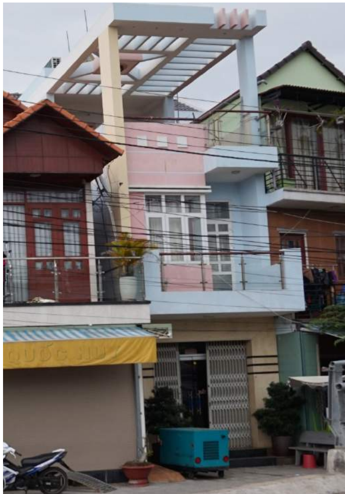
b) Nhà ba tầng, mái bằng bê tông cốt thép
