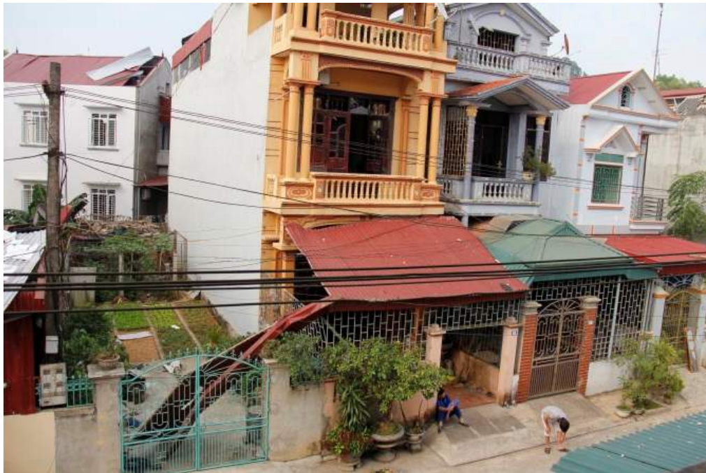
b) Nhà hai tầng, mái bằng bê tông cốt thép
