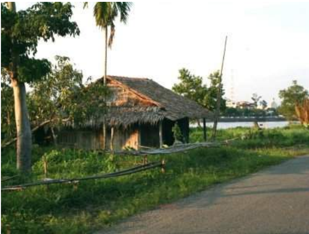
b) Nhà một tầng chỉ có tường xây gạch bền chắc, không có cột, mái lá
